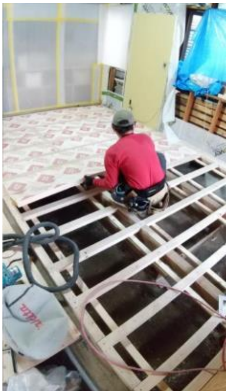
一度解体し断熱を施す
