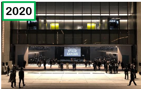
2020 TACHIKAWASTAGE GARDEN 2階席後方の壁を開放することで、屋内外を一体で利用することができる多機能ホール
